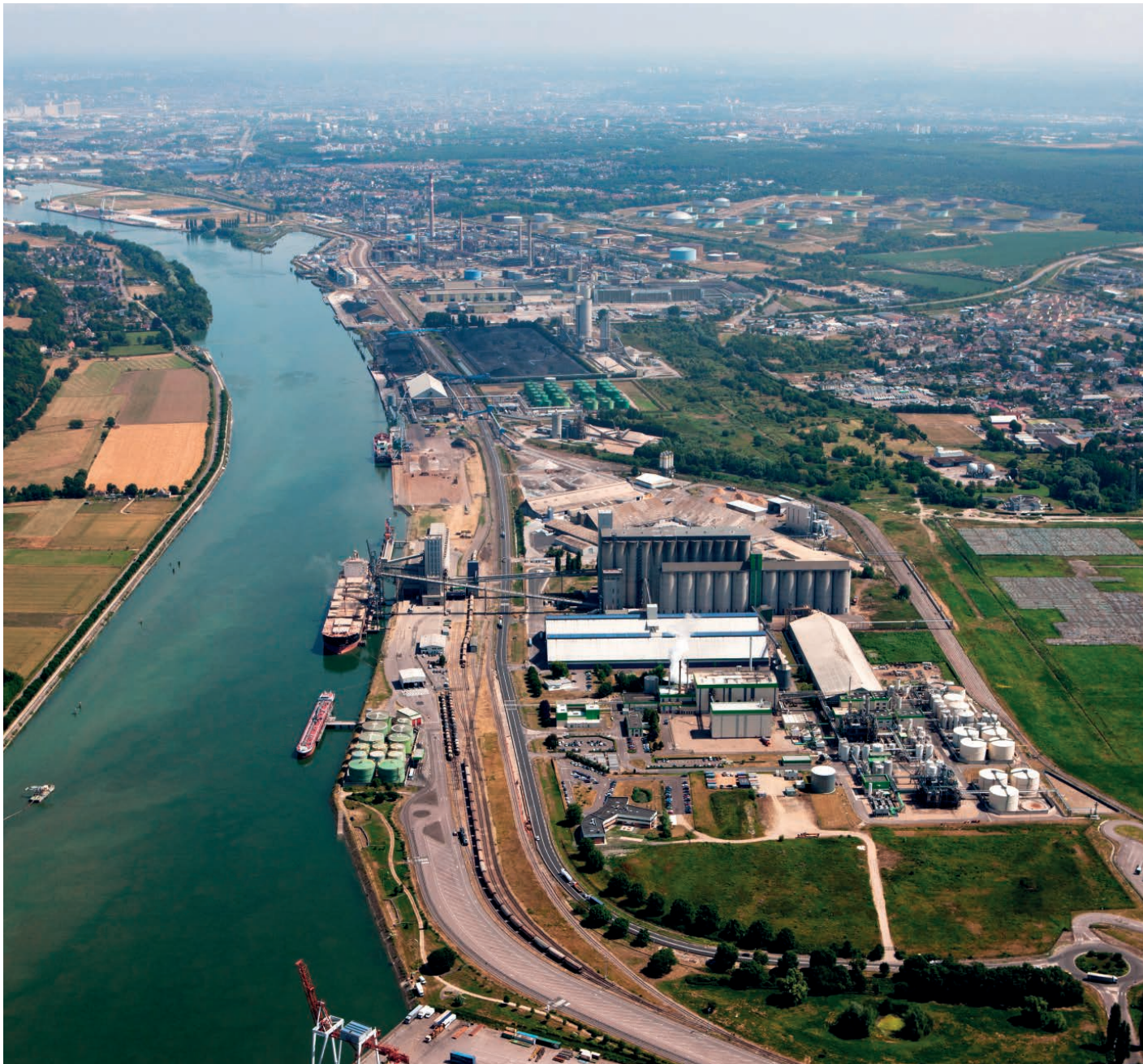
Saipol plant, Grand-Couronne, Seine-Maritime, France
