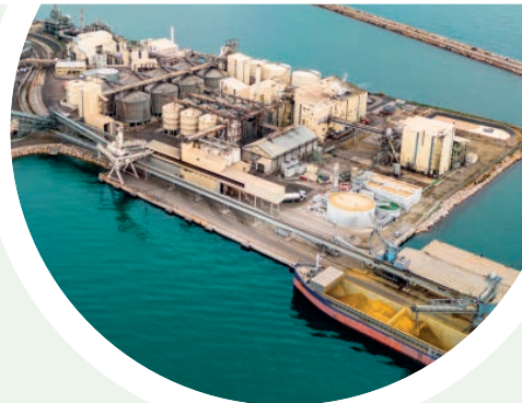
Saipol plant, Sète, Hérault, France
