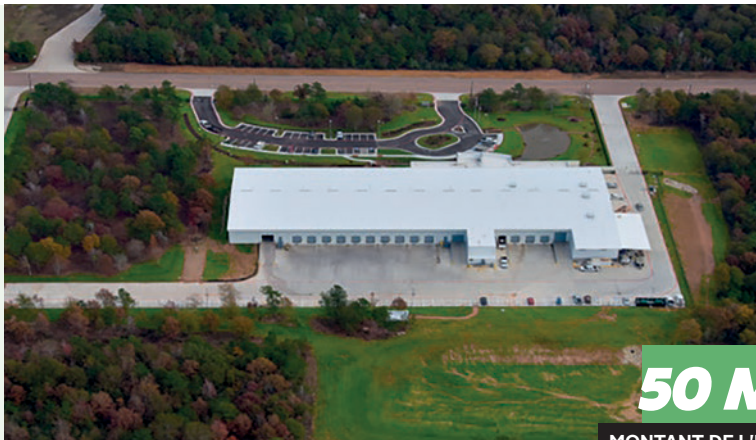
Nouvelle usine Oleon - Conroe (Texas, États-Unis)
